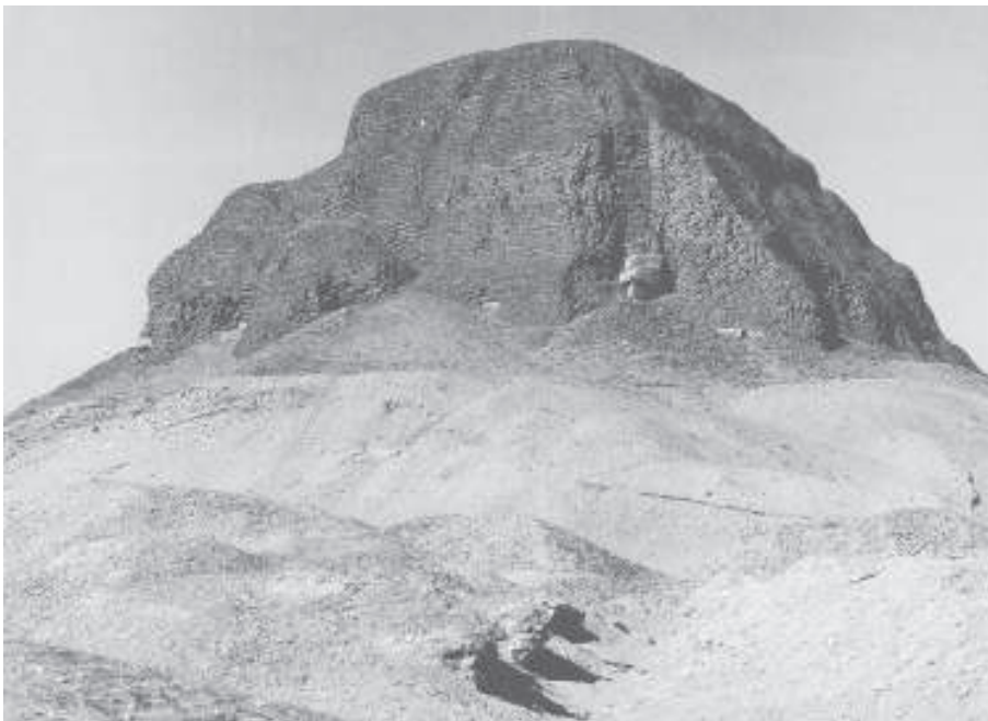
Abb. 16: Pyramide Sesostris' II. in el-Lahun. Deutlich sichtbar ist das sternförmige Kalksteingerippe. Aus Rainer Stadelmann, Die ägyptischen Pyramiden , 1991.
